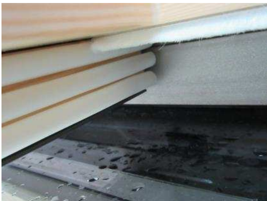
Bild 9 Mitteldichtung am Schiebeflügel, Ansicht oben
