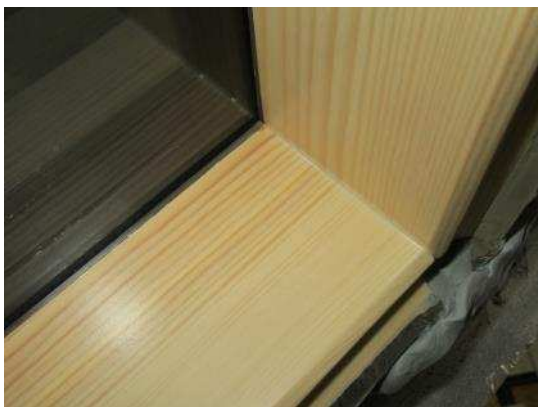
Bild 5 Eckverbindung Blendrahmen, Innenansicht
