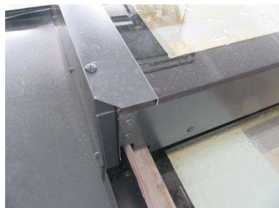
Bild 18 Schiebeflügel Eckausbildung am Festfeld oben, Ansicht außen
