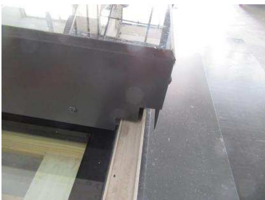
Bild 17 Schiebeflügel Eckausbildung am Festfeld unten, Ansicht außen
