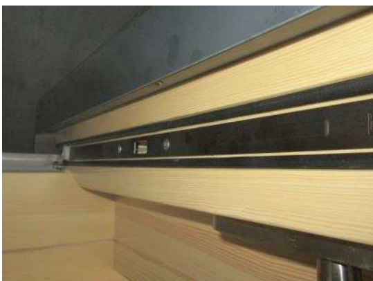
Bild 11 Falzansicht Flügel
