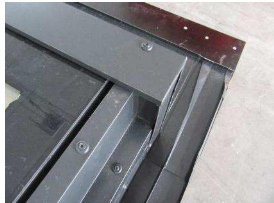
Bild 16 Schiebeflügel Eckausbildung oben, Ansicht außen
