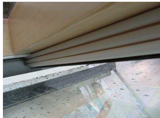
Bild 10 Mitteldichtung am Schiebeflügel, Ansicht unten
