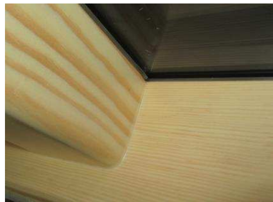
Bild 6 Anbindung Mittelbund am Blendrahmen, Innenansicht
