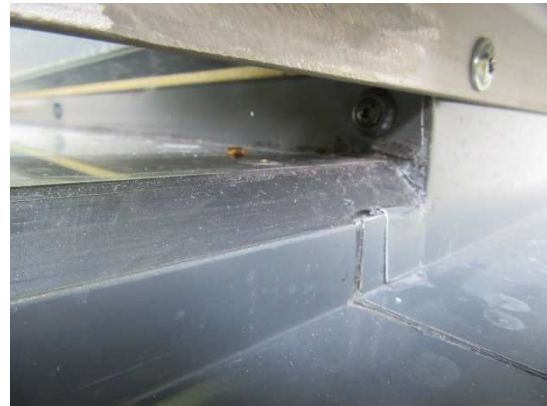
Bild 14 Detail: Glasklebung am Festfeld
